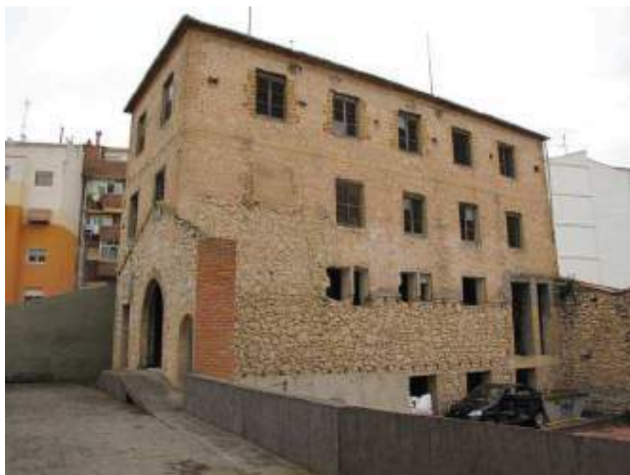
Zona de afección. Modificación 6 con los restos del Molí de la Plaça de la Palla
