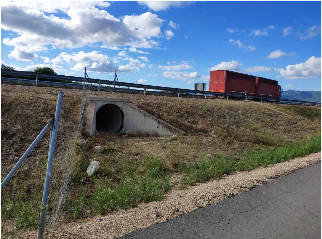
**Fotografía 65 Vista de obra de drenaje transversal de la A-7 en el Sector. Fuente: Elaboración propia. Fecha: 08/09/2020**
